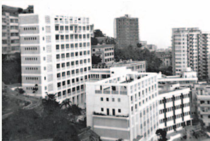
■舊校舍位於斜坡，不搬校難以重建。
